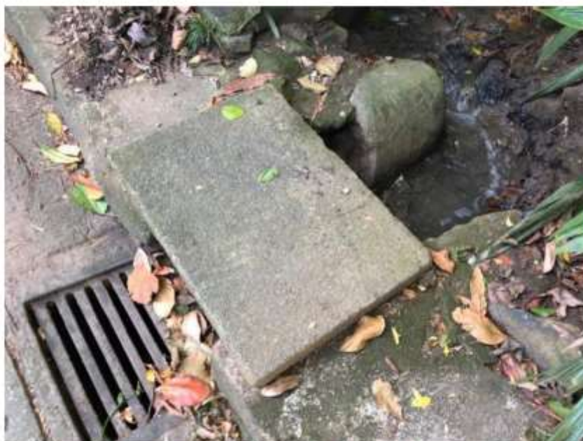
Figura 4 - Dispositivo de drenagem com manutenção inadequada
