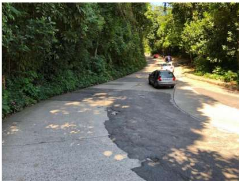
Figura 2 - Defeitos no pavimento de concreto
